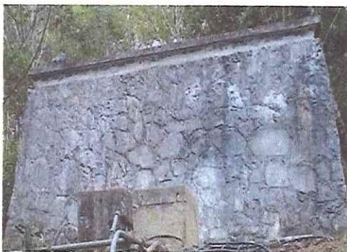
TANQUE DE ALMACENAMIENTO CENTRO MAV-EDNH-0006
