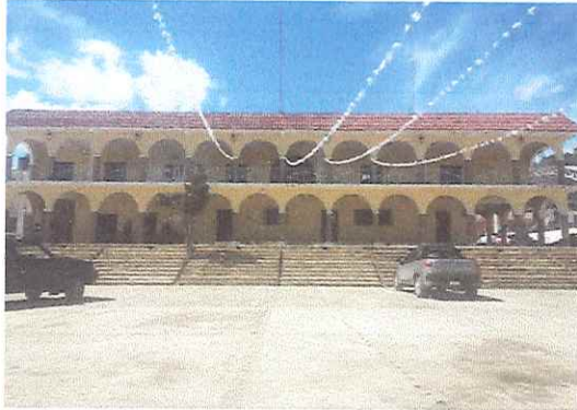
PALACIO MUNICIPAL OFICINAS
